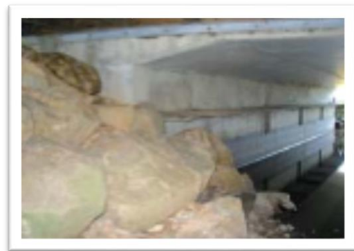
Figure n° 152 : Encorbellement (passage à sec sous un pont)
