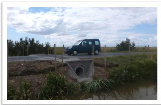
Figure n° 151 : Passage busé sous la route à Champagné-les-Marais ©PNR Marais poitevin
